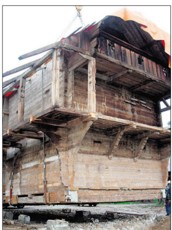
Der Spycher wird abgehoben. (Bild: uss)
